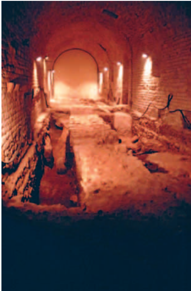
Fig. 189. Volta de sosteniment del refetor de la Canònica.
