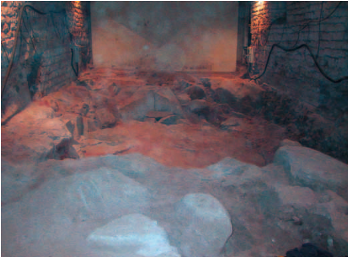
Fig. 190. La construcció de la sala de sosteniment del sector occidental del claustre va fer necessaris importants retalls de la roca al costat meridional.
